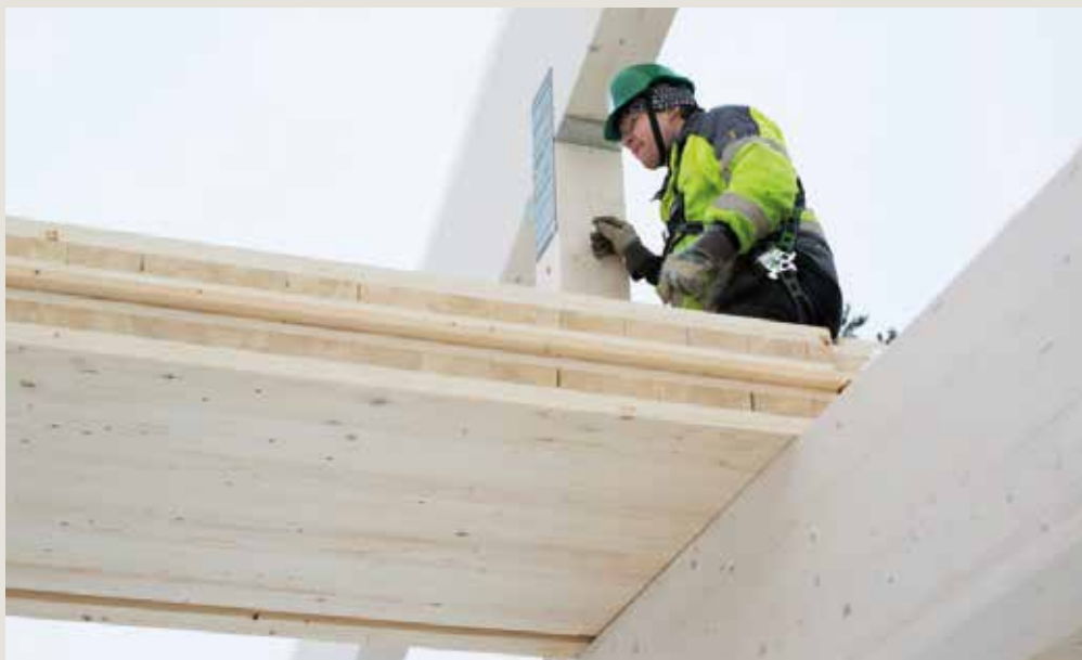
Massivtreleverandøren Splitkon bruker materialer fra norske skoger
